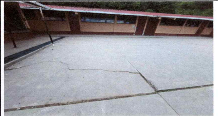
Foto 4: LOSA DE PATIO DE 10 CM. DE ESPESOR CON FISURAS Y HUNDIMIENTO
