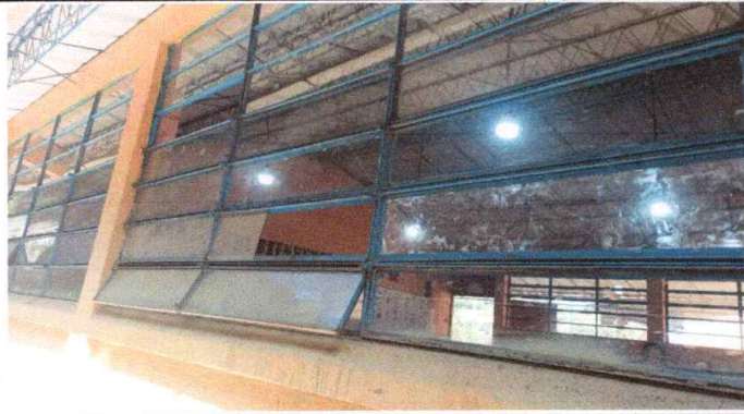
Foto 1: VIDRIO TRANSPARENTE QUEBRADO DE 5 MILIMETROS DE GROSOR CON MEDIDAS DE 20x60CM
